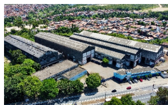
Mecânica / Caldeiraria Maceió/AL
