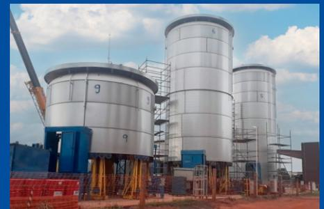
Diferencial Dedini: Sistema de macacos altamente avançado e eficiente para a fabricação de tanques de grande porte
